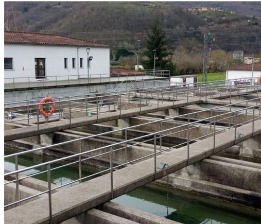
Instalación de una turbina hidráulica de 50 kW en la Planta de Tratamiento de Agua Potable
