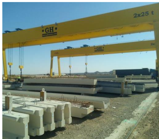
Modernización de planta de prefabricados de hormigón
