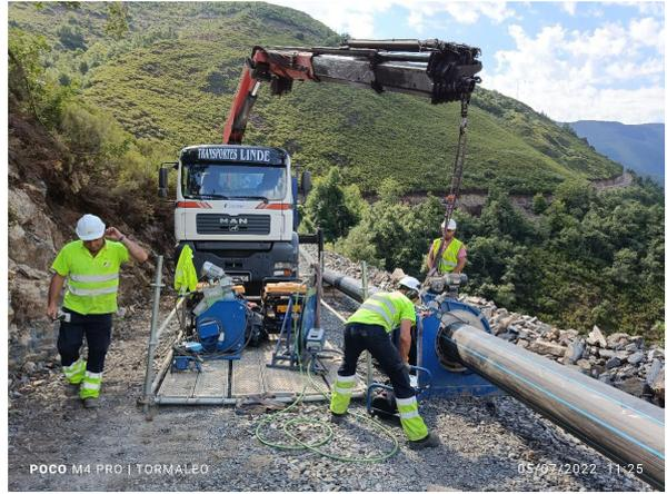
Trabajos de adecuación antiguo camino vecinal Fondosdevilla-Villarín. Soldadura y montaje tubería de desagüe.
