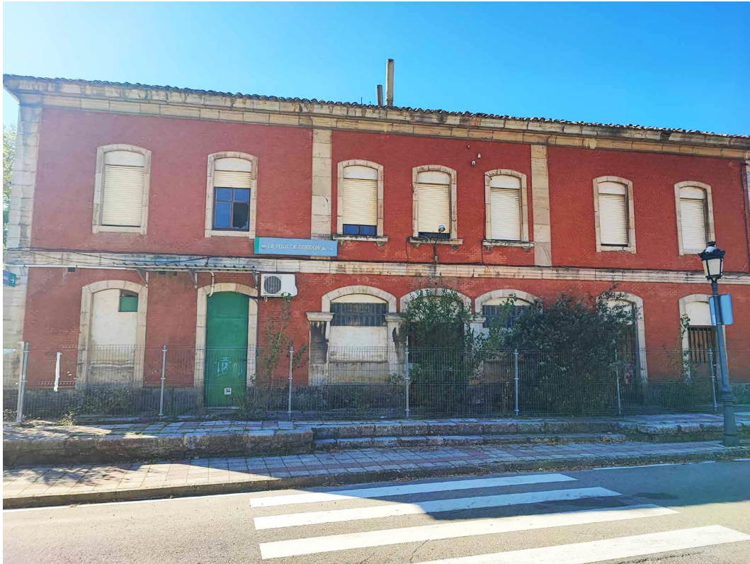
Rehabilitación estación ferroviaria de La Pola de Gordón para albergue de los Caminos a Santiago
