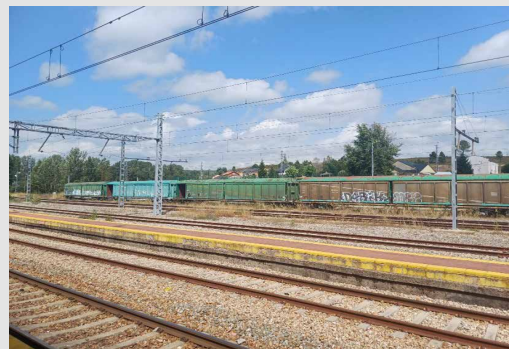
Futuros vagones rehabilitados
