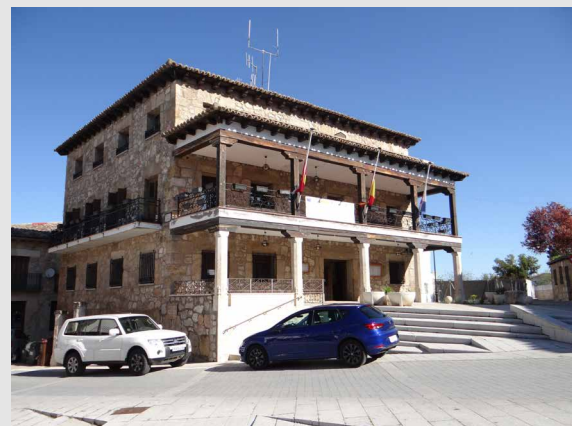
ALMONACID DE ZORITA. Rehabilitación del ayuntamiento
