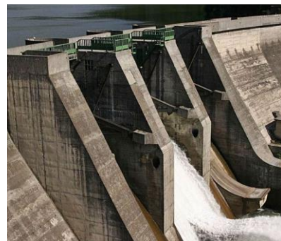
Aprovechamiento hidroeléctrico Rioseco
