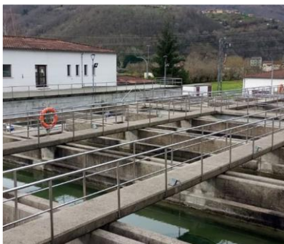
Instalación de turbina hidráulica la Planta de Tratamiento de Agua Potable
