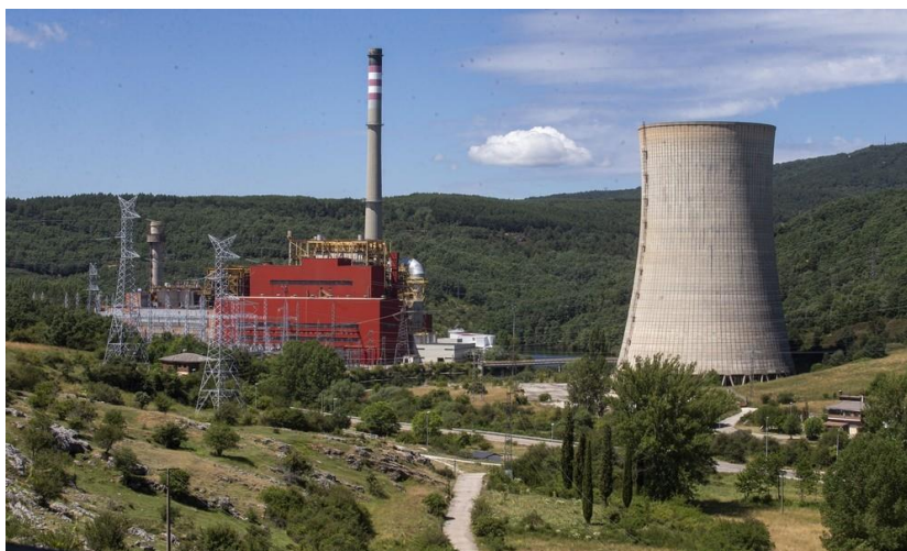
(Imagen central térmica de Velilla. Fuente: El Periódico de la Energía)
