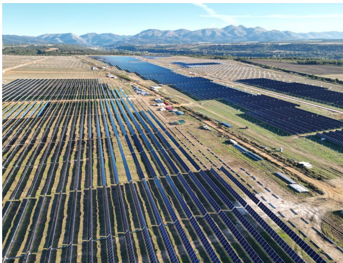
(Obras de la planta en Villalba de Guardo)
