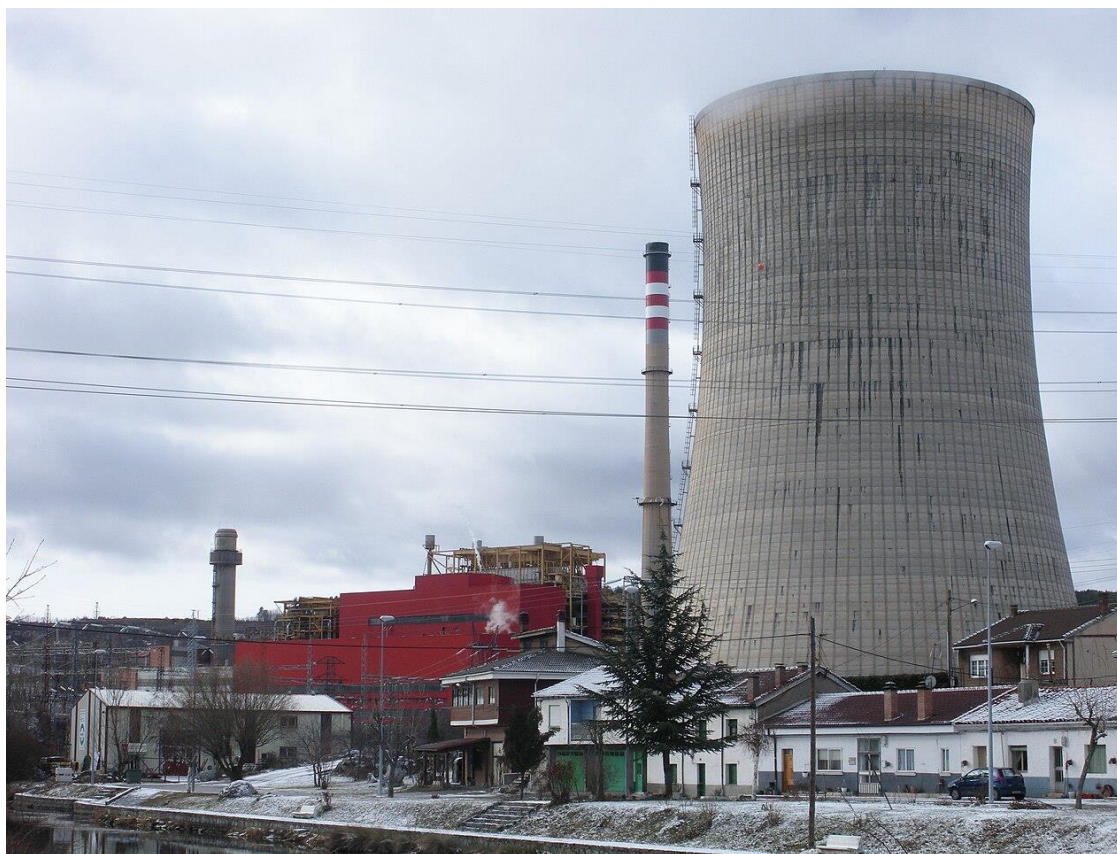
(Imagen de la Central Térmica de Velilla)
